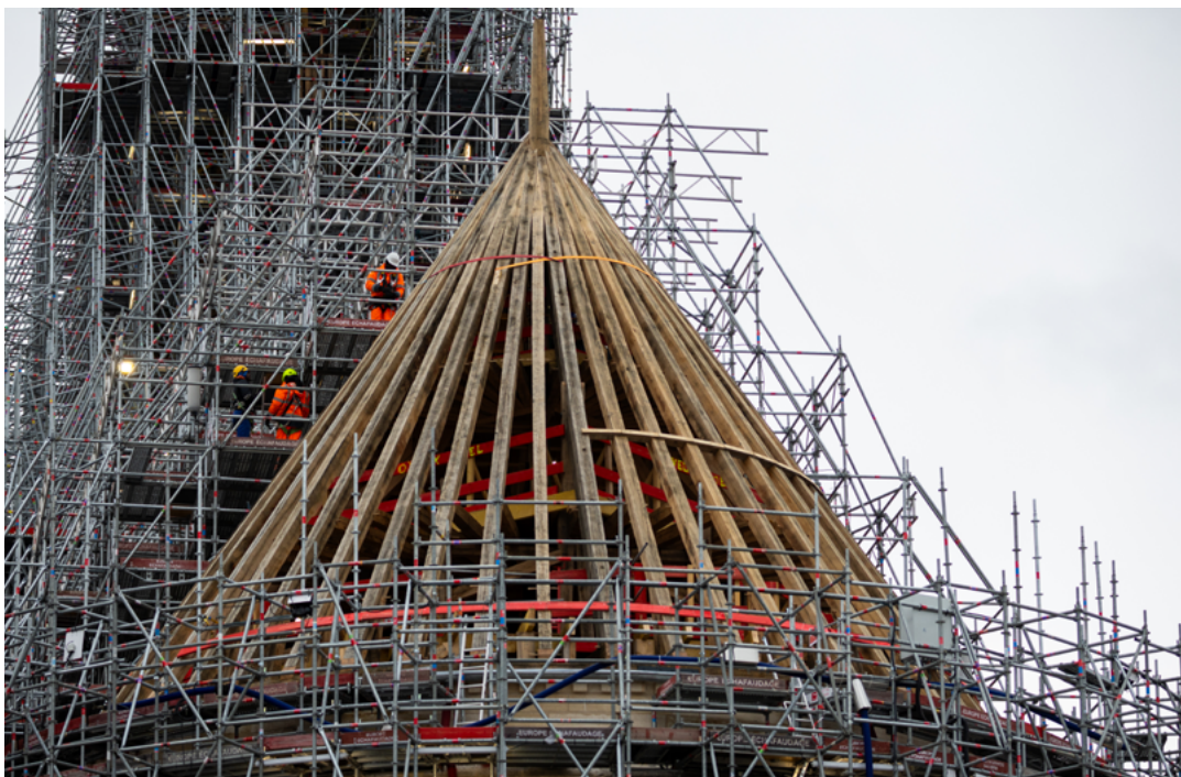
Levage de la charpente du chœur
